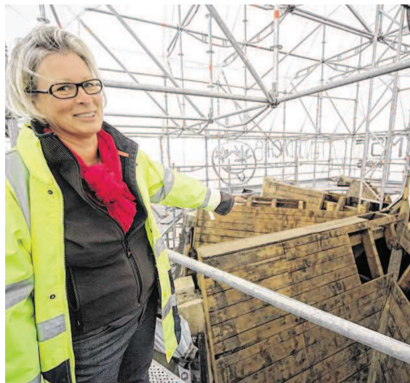
Auf der Spitze: Architektin Dorothee Völlings-Grube beaufsichtigt die Restaurierung des St. Josef-Kirchturms. Statt eines Schieferdachs erhält die Spitze wie schon das Hauptschiff drei Jahre zuvor bald eine Metalldachung.
