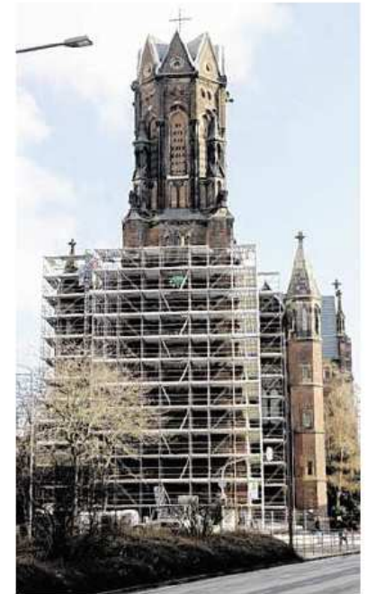
Sanierungsfall: Der Turm der Grabeskirche St. Josef verschwindet hinter einem Gerüst. Fotos: Jaspers
